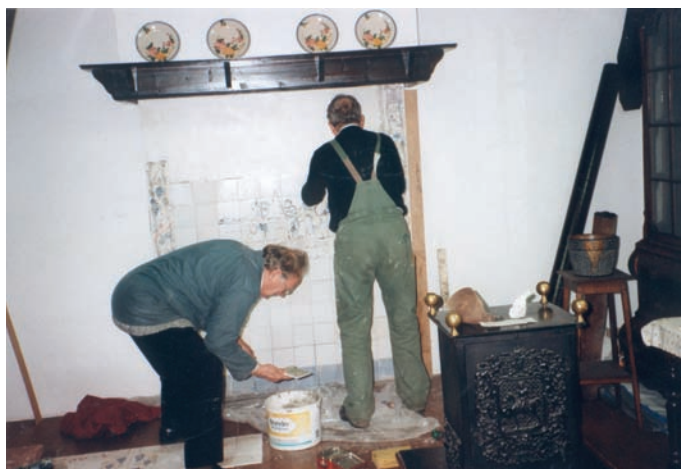
Hein Wieggers en Stef Nieuwenhuizen bezig met het tegeltableau
